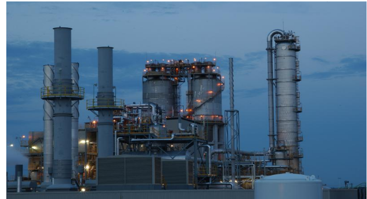
Usine de Montréal-Est (Canada)
